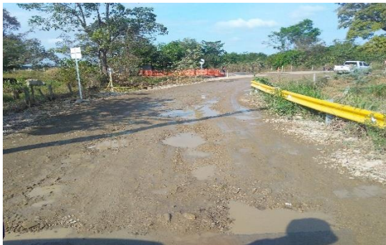
Antes de Estabilizar Proyecto Grantierra Energy, San Martín, Cesar, Colombia
